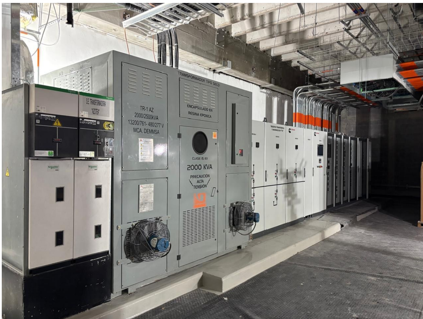
ARREGLO DE SUBESTACIÓN ELECTRICA EN AZOTEA DURANTE REMODELACIÓN
