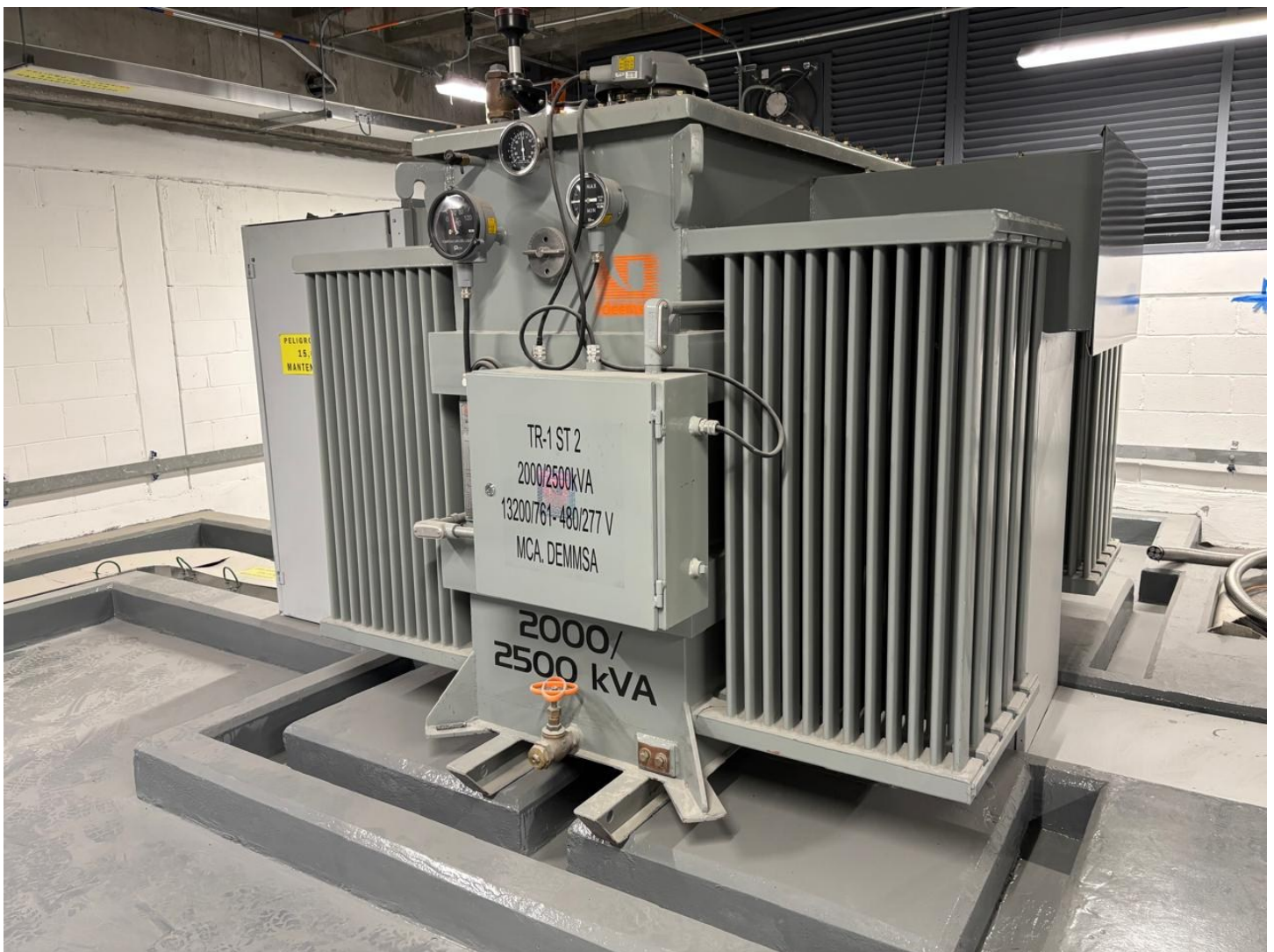
INSTALACIÓN DE TRANSFORMADOR TIPO SUBESTACIÓN
