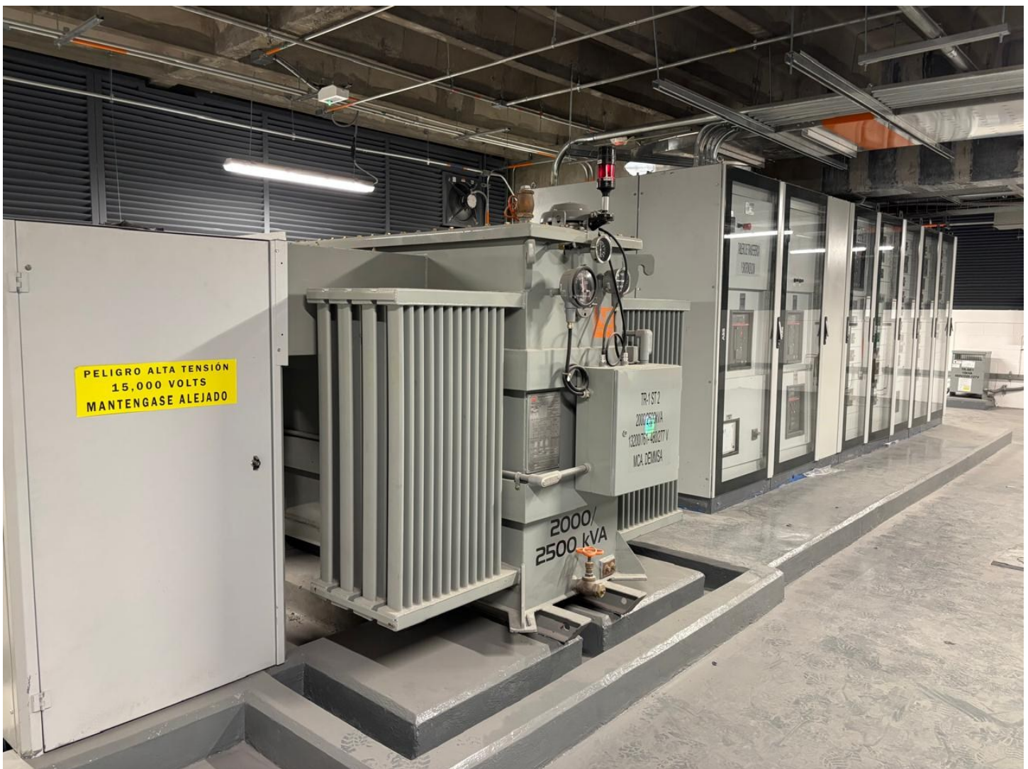
ARREGLO DE SUBESTACIÓN EN SOTANO 2
